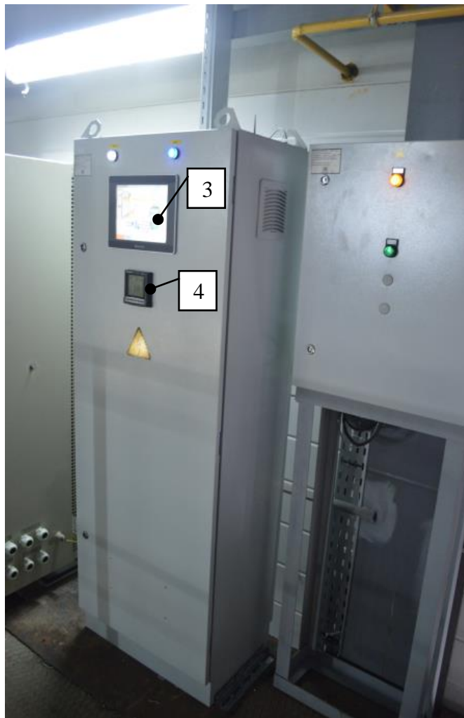
Шкаф управления и силовой шкаф (Системы автоматического управления)
